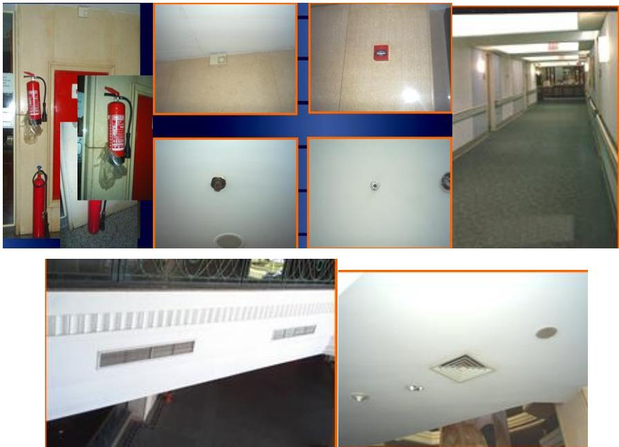
صور ميدانية توضح أماكن تواجد طفایات الحريق واماكن مخارج التکییف واماكن تواجد انذار الحرائق وتوضح الصور أماكن الاشارات التي تؤدي الى سلام الهروب بالطرقات
